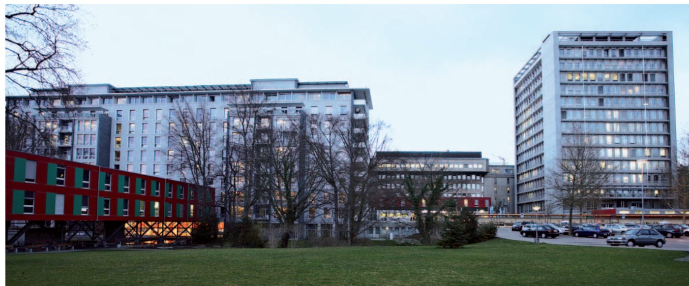
Hôpital régional de Winterthur, en Suisse
