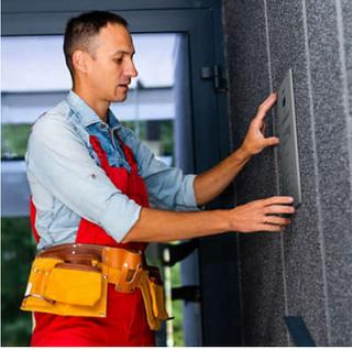
Mit einer einzigen Stromversorgung pro Installation (unabhängig davon, wie viele Bildschirme im Gebäude vorhanden sind) und der vorhandenen BUS-Kommunikationsvorrichtung wird die Anzahl der Anschlusskabel reduziert (Kabel müssen nicht in jedem Gebäude gezogen werden). Die Installationsmethode der Philips WelcomeHive Pro 2 Serie wurde für Profis und Installateure entwickelt.
