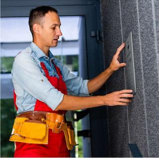
Im Vergleich zum Vorgängermodell bietet das Philips WelcomeHive Pro 2 eine vereinfachte Installation für Profis: Nur ein einzelnes Netzteil ist erforderlich, unabhängig von der Anzahl der beteiligten Einheiten. Das BUS-System reduziert die Anzahl der erforderlichen Kabel, es müssen also keine Kabel in der Haustürstation verlegt werden, und der Bildschirm kann schnell an einer Säule oder Wand befestigt werden
