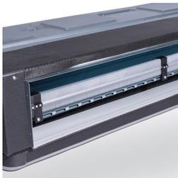
防漏水双重保护：内置接水盘，标配浮子开关，选配冷凝水泵，水位过高报警保护，有效防止冷凝水溢出。
